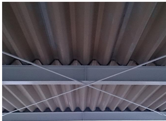
塗装後のカーポート内部
